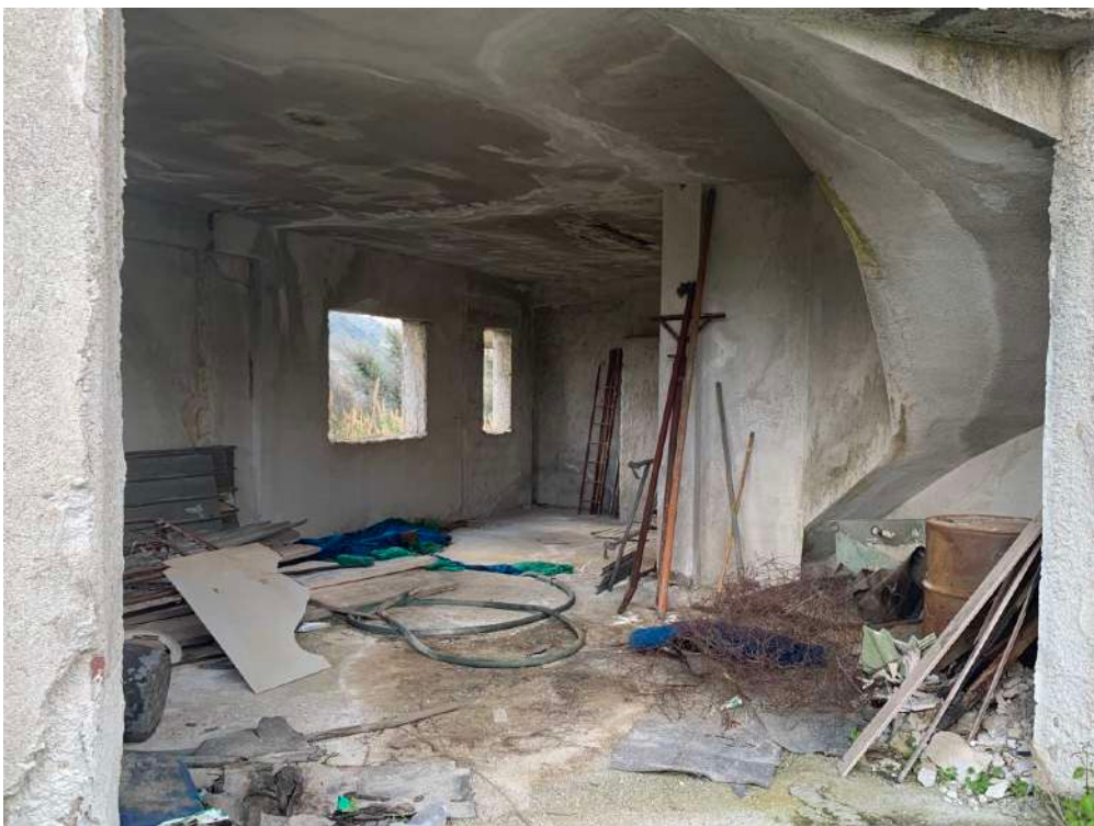
Foto n. 4 - Rudere alla particella 770
