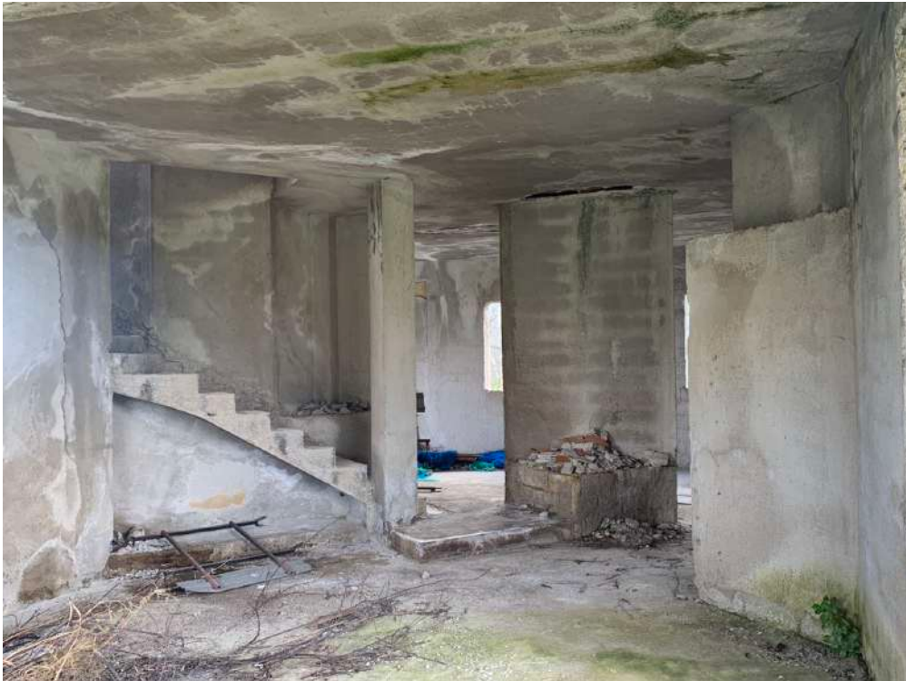
Foto n. 5 - Rudere alla particella 770
