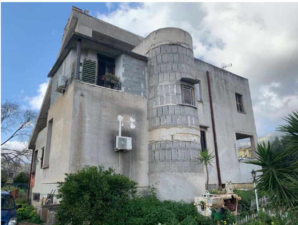
Foto n. 11 - Villa alla particella 726
