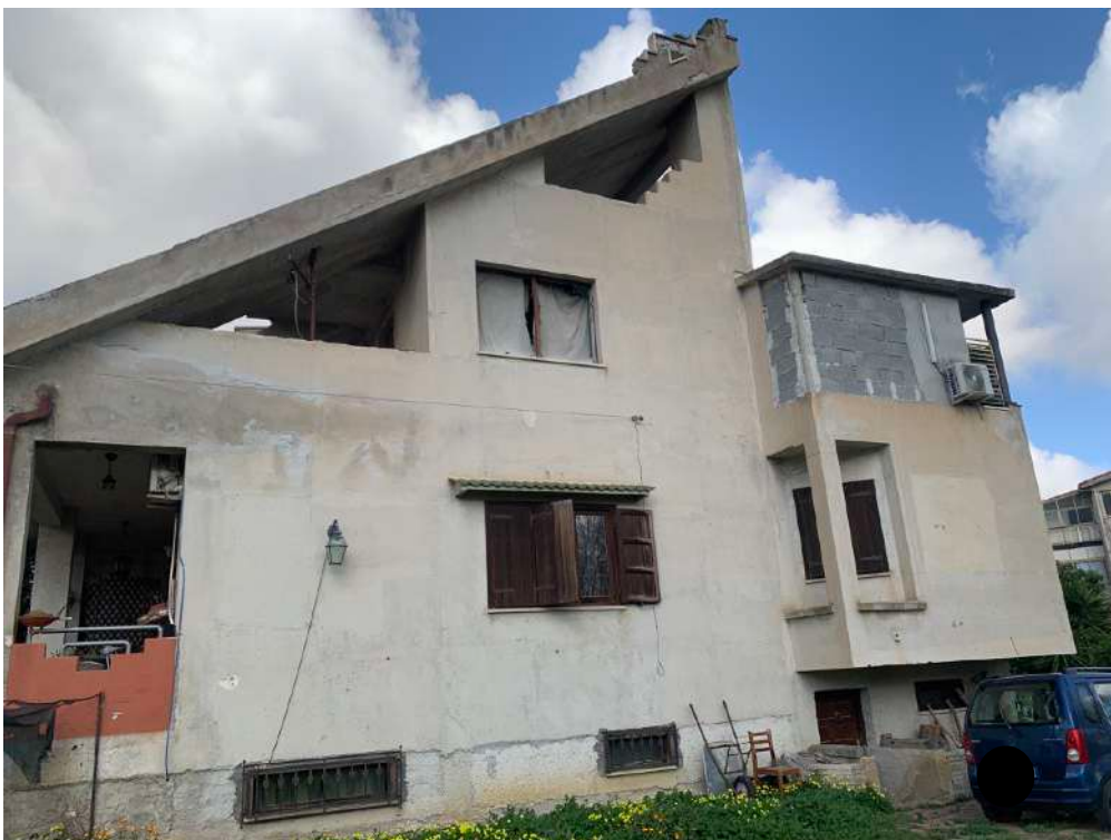
Foto n. 10 - Villa alla particella 726
