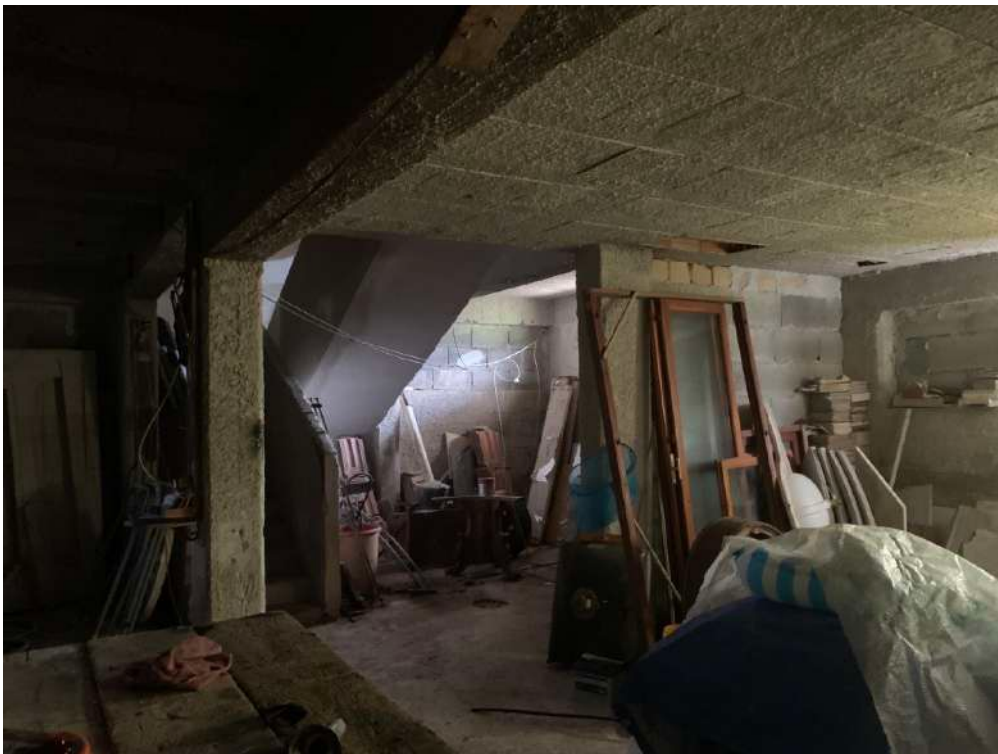
Foto n. 36 - Villa alla particella 726: Cantina
