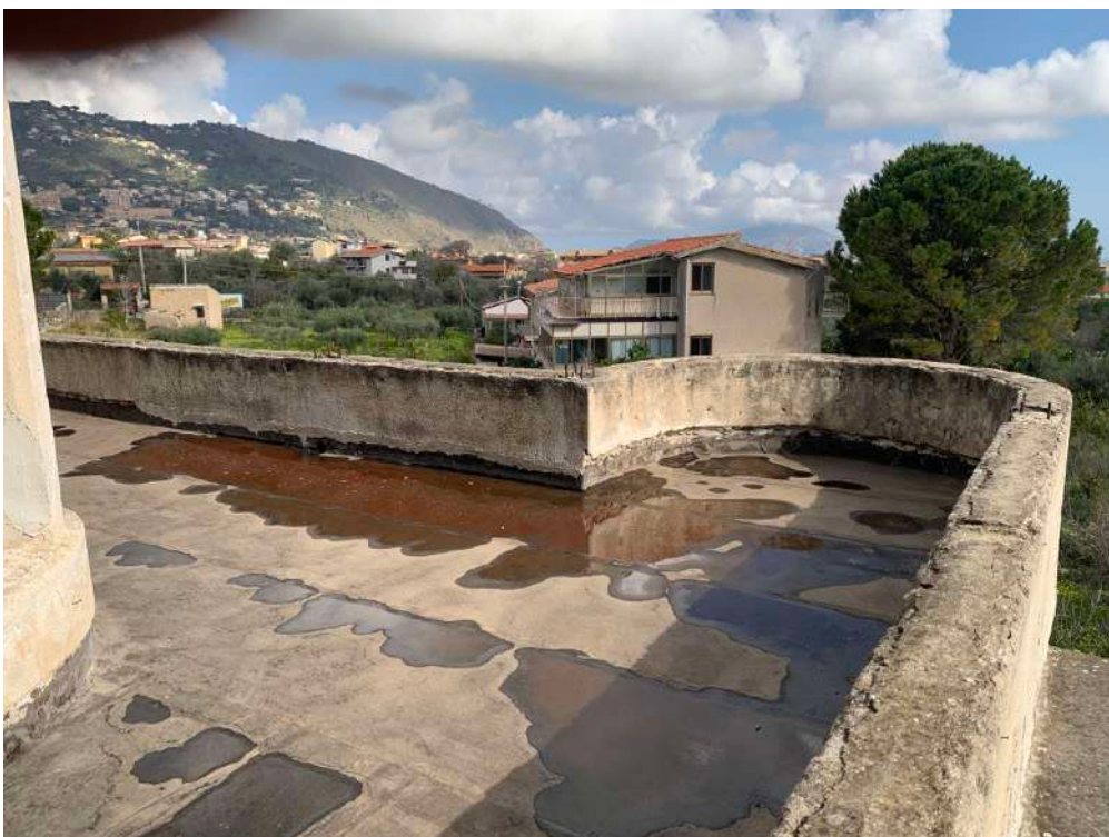
Foto n. 30 - Villa alla particella 726: Terrazzo
