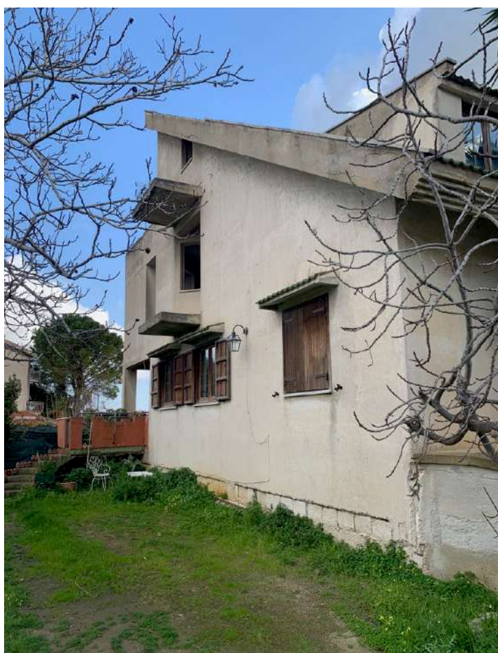
Foto n. 14 - Villa alla particella 726
