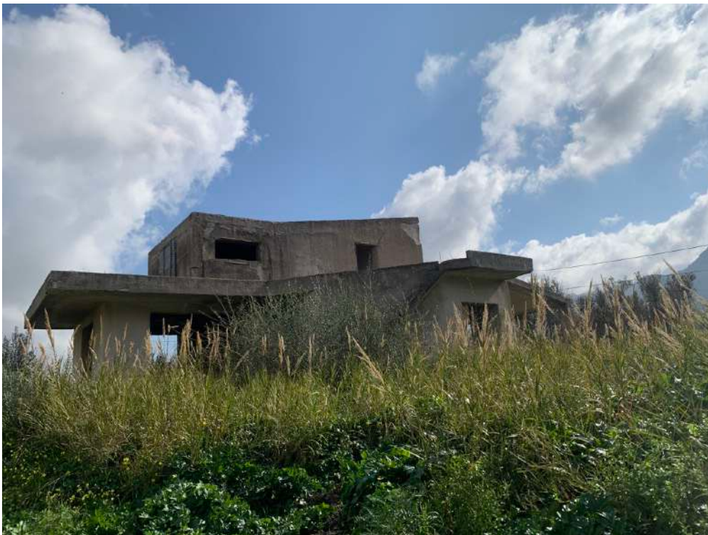
Foto n. 8 - Rudere alla particella 770
