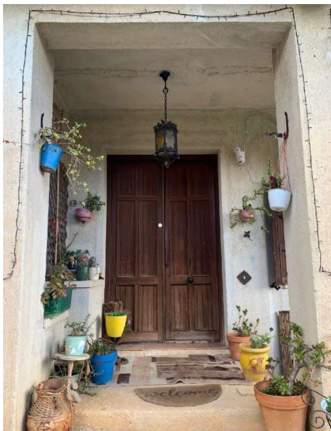
Foto n. 17 - Villa alla particella 726: Porta d'ingresso
