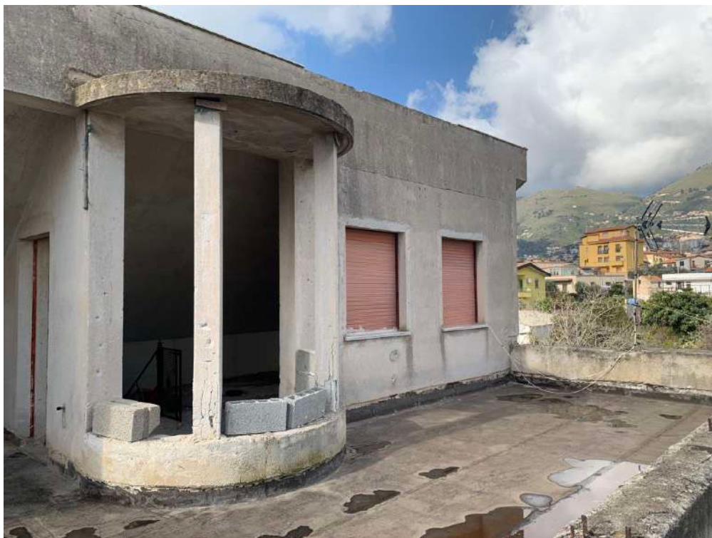
Foto n. 31 - Villa alla particella 726: Terrazzo
