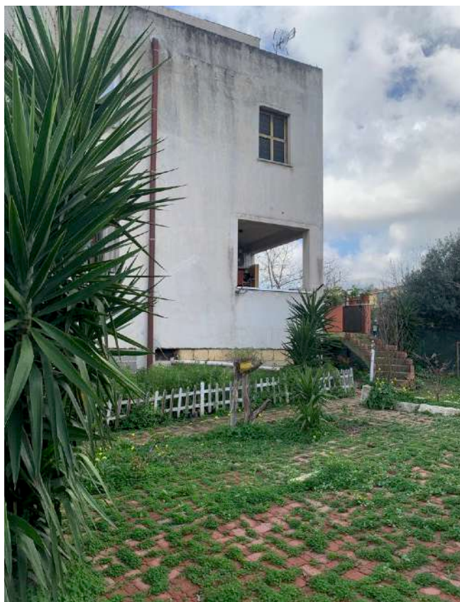
Foto n. 15 - Villa alla particella 726
