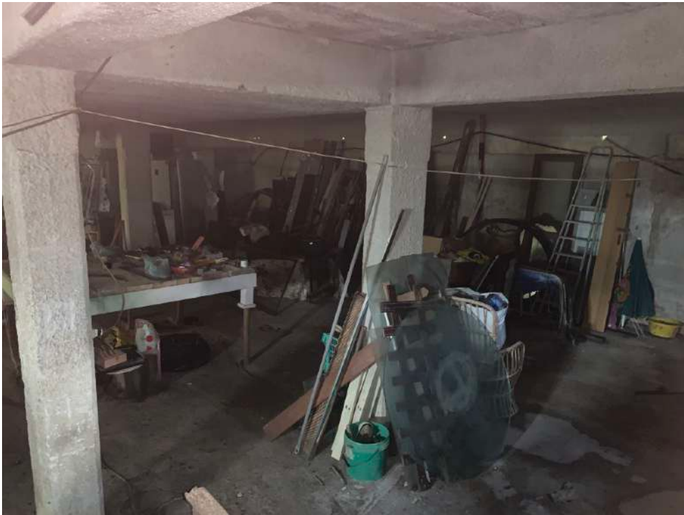
Foto n. 35 - Villa alla particella 726: Cantina
