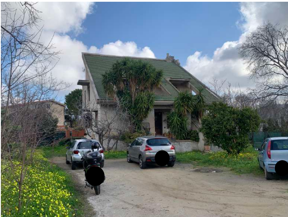
Foto n. 9 - Villa alla particella 726
