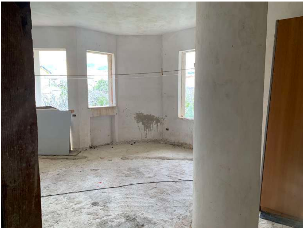
Foto n. 29 - Villa alla particella 726: Piano Primo
