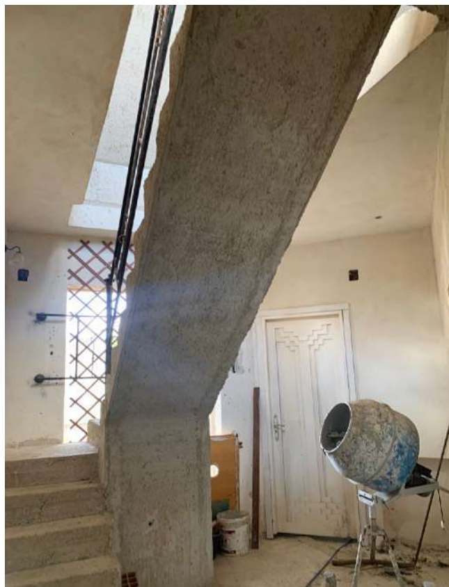
Foto n. 28 - Villa alla particella 726: piano primo
