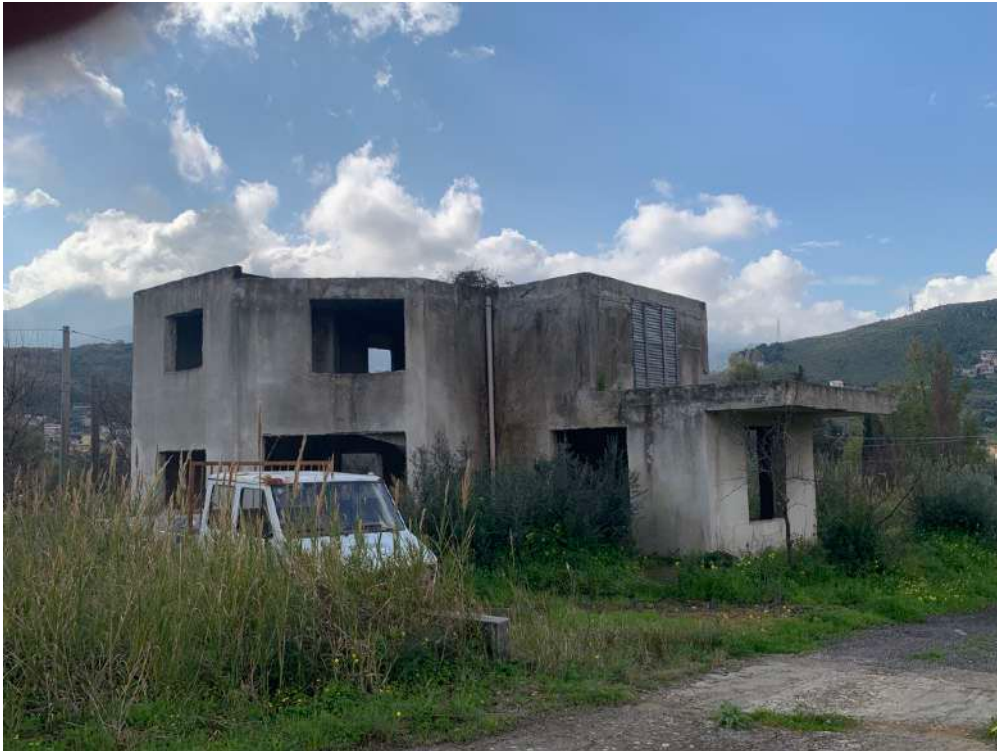
Foto n. 3 - Rudere alla particella 770
