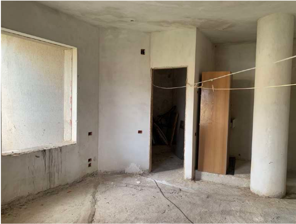
Foto n. 27 - Villa alla particella 726: Piano Primo
