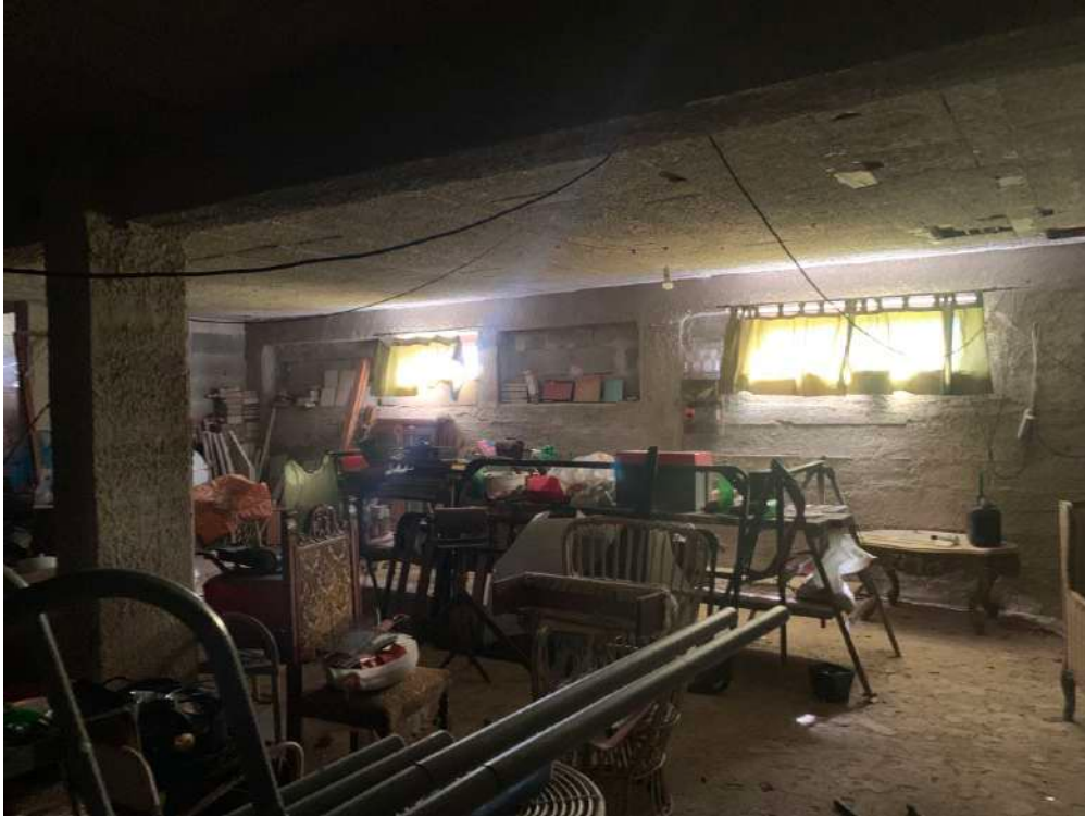
Foto n. 37 - Villa alla particella 726: Cantina
