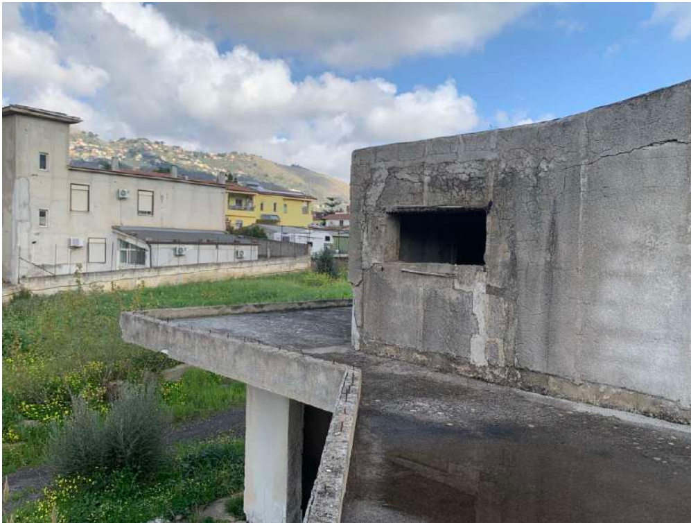
Foto n. 7 - Rudere alla particella 770
