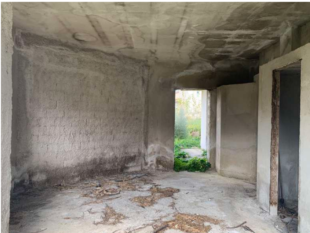
Foto n. 6 - Rudere alla particella 770
