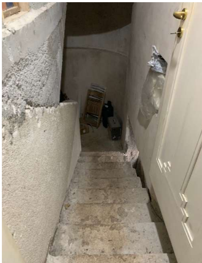
Foto n. 33 - Villa alla particella 726: scale verso la cantina
