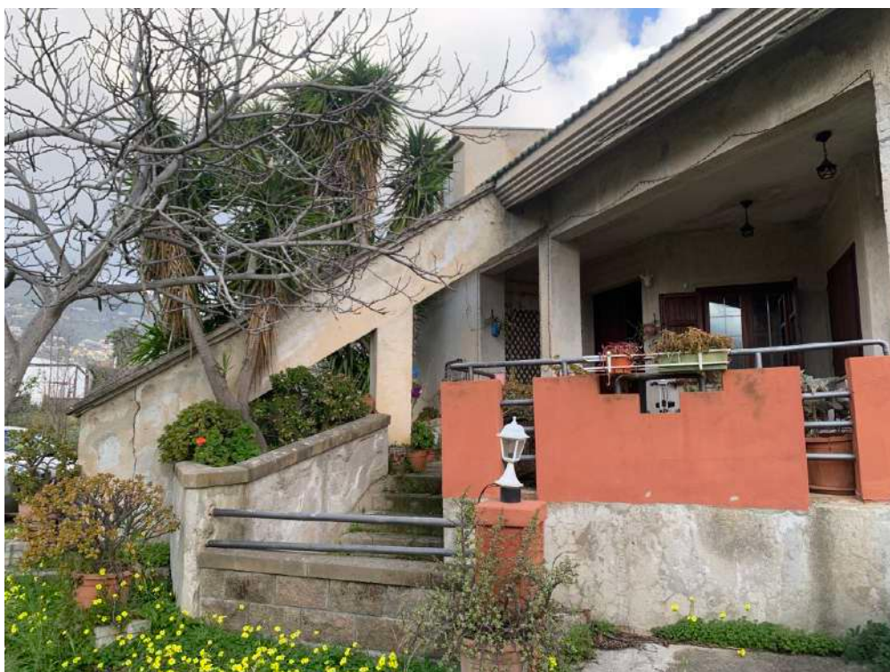
Foto n. 13 - Villa alla particella 726
