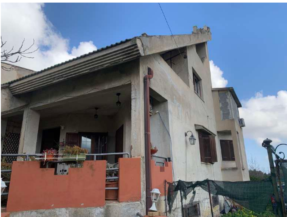
Foto n. 12 - Villa alla particella 726
