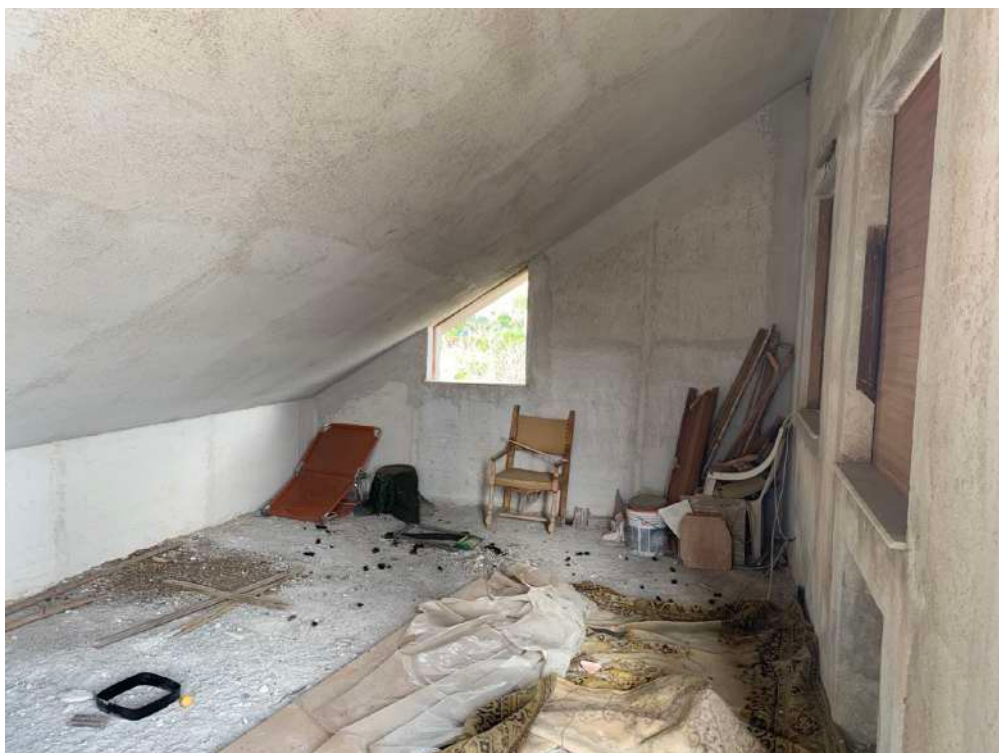
Foto n. 32 - Villa alla particella 726: Mansarda
